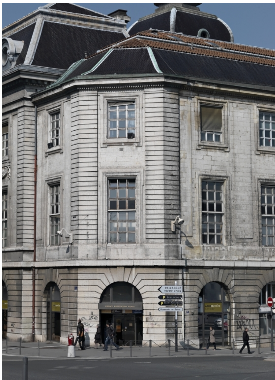
Bâtiment A. Façade du pan coupé à l'angle de la rue de la Barre et du quai Jules-Courmont
