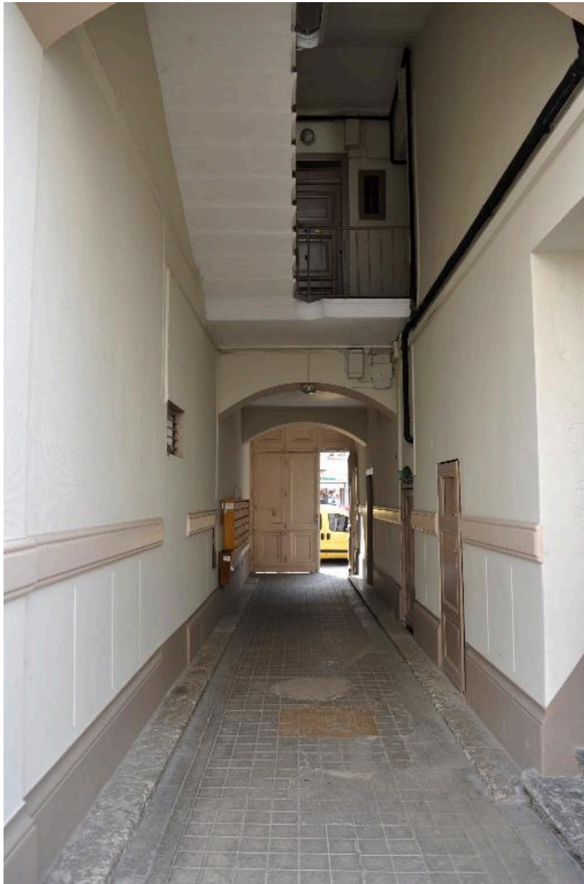
Immeuble sur rue, vue du passage cocher enjambé par la cage d'escalier
