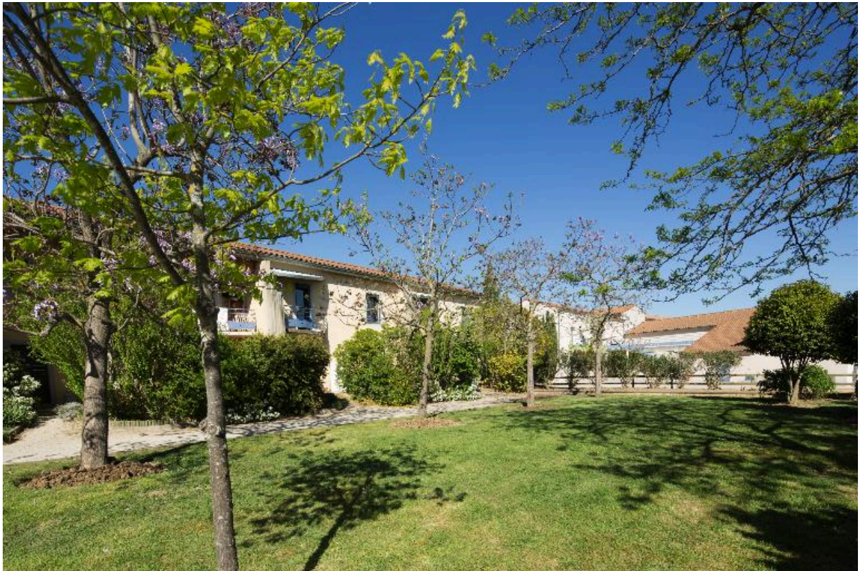
Foyer logement : façade sud
