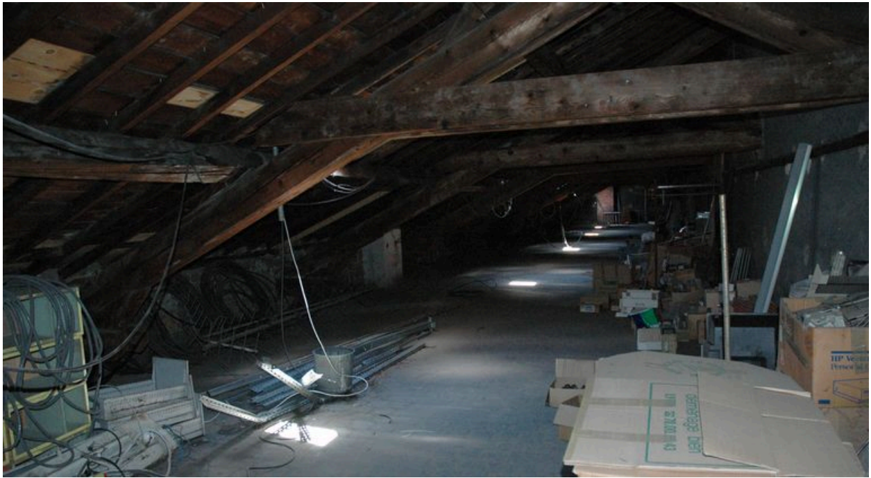
Bâtiment de la galerie, combles
