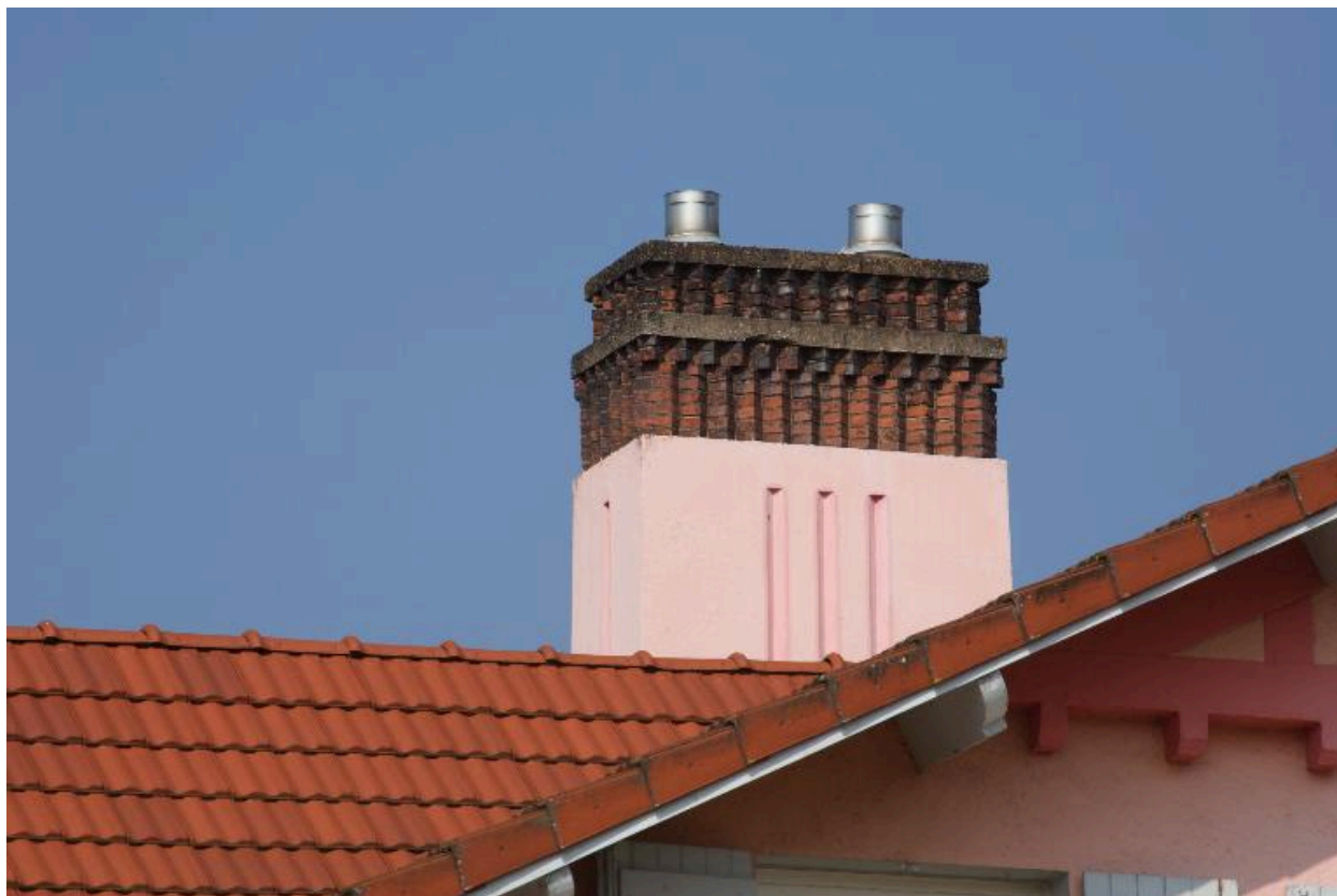
Bât. A : détail de la tour cheminée
