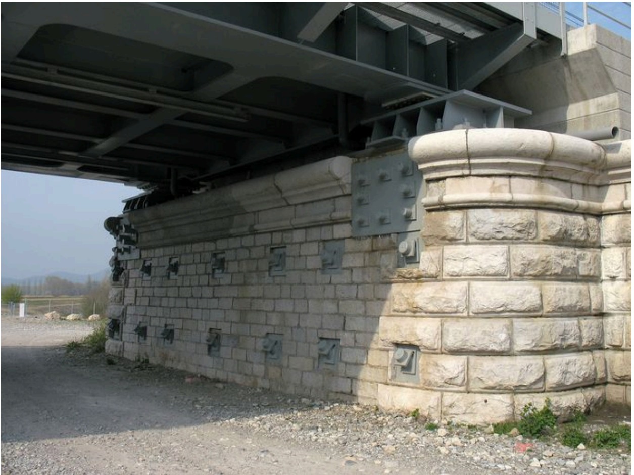
Vue de la culée rive droite (vue partielle), conservée dans l'ouvrage actuel
