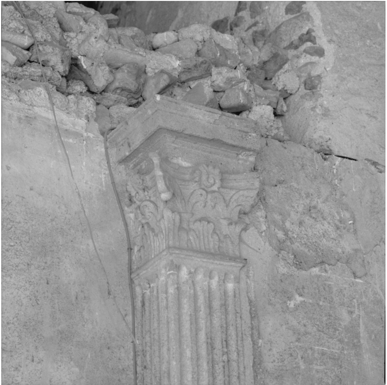
Corps de logis, 2e étage : détail d'un troisième chapiteau de la grande pièce.
