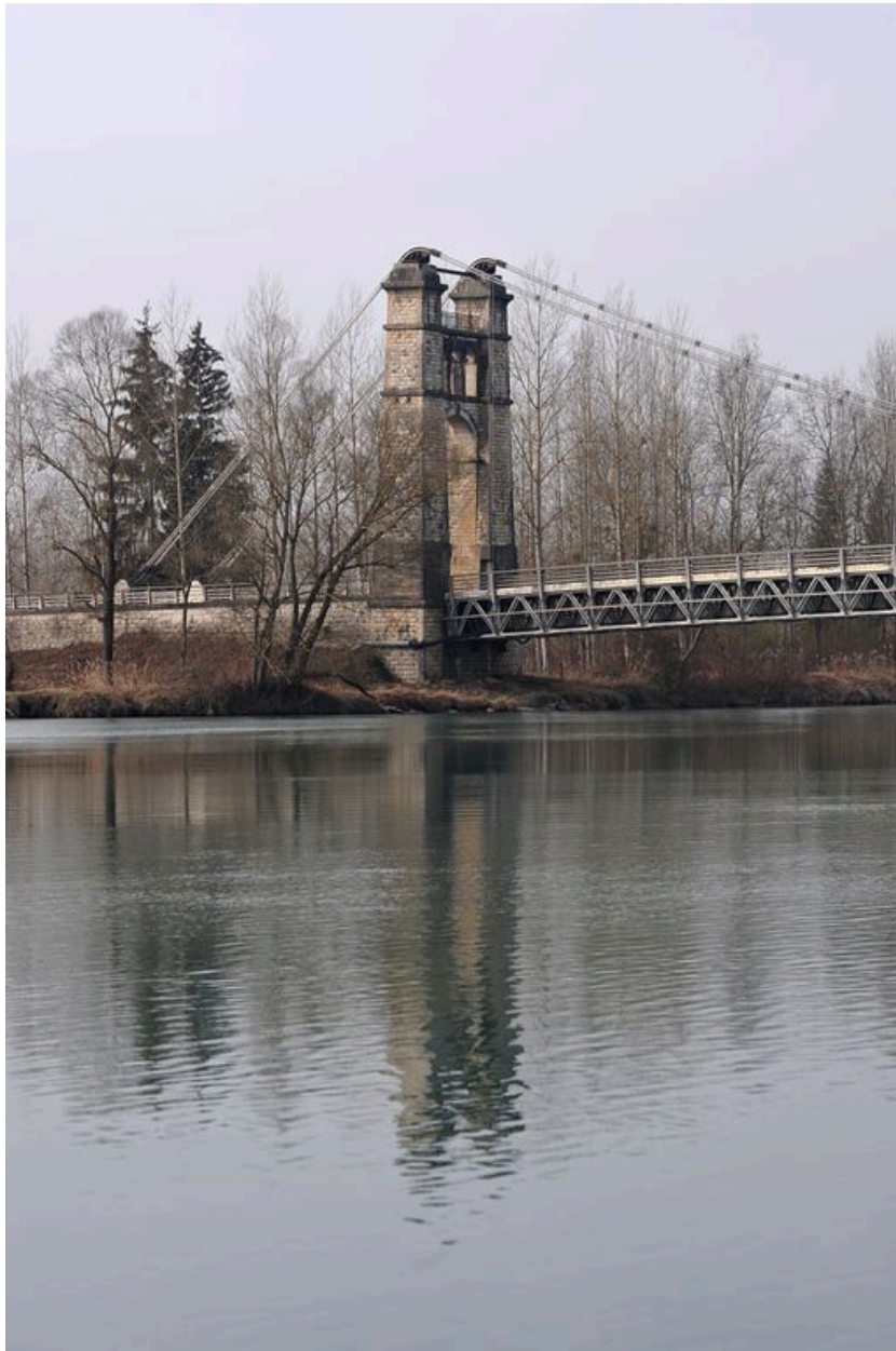
Vue partielle, pylône gauche, face amont (depuis la rive droite)
