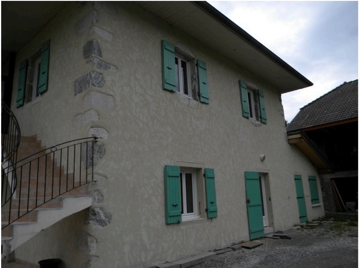
Mur pignon d'une ancienne ferme (2008 A5 2308/2511).
