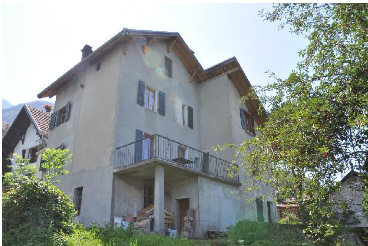
Mur pignon nord du troisième moulin
