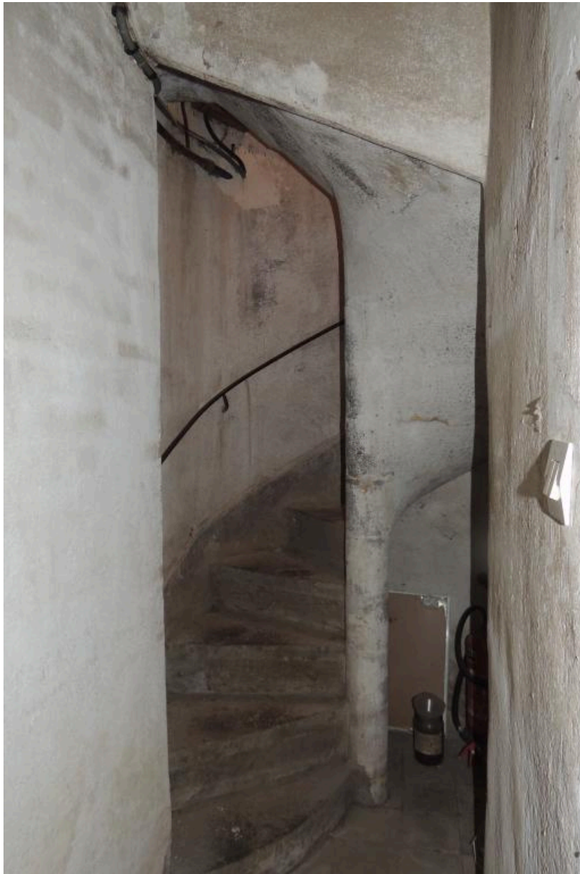
Départ de l'escalier sud-est
