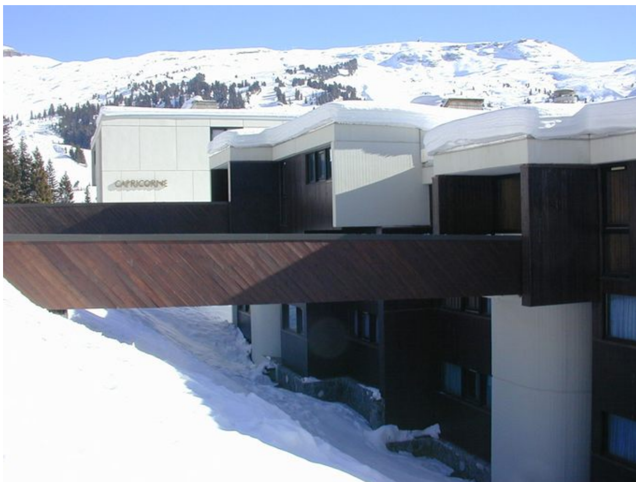
Elévation antérieure et passerelle d'accès depuis le nord
