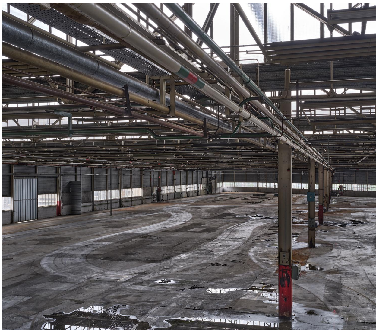
Intérieur de l'atelier O26, désaffecté.
