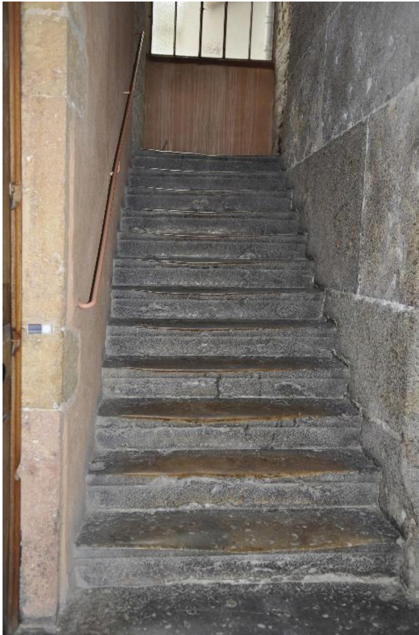
Départ de l'escalier du n°12 rue Dumenge commun avec le n°14
