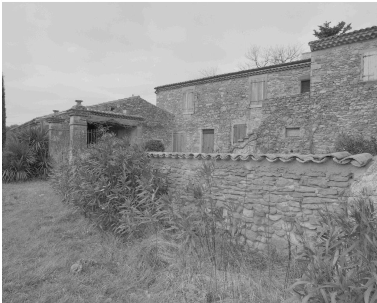
La Grand Grange, route de Rousset. Vue d'ensemble de la ferme (A3 399).
