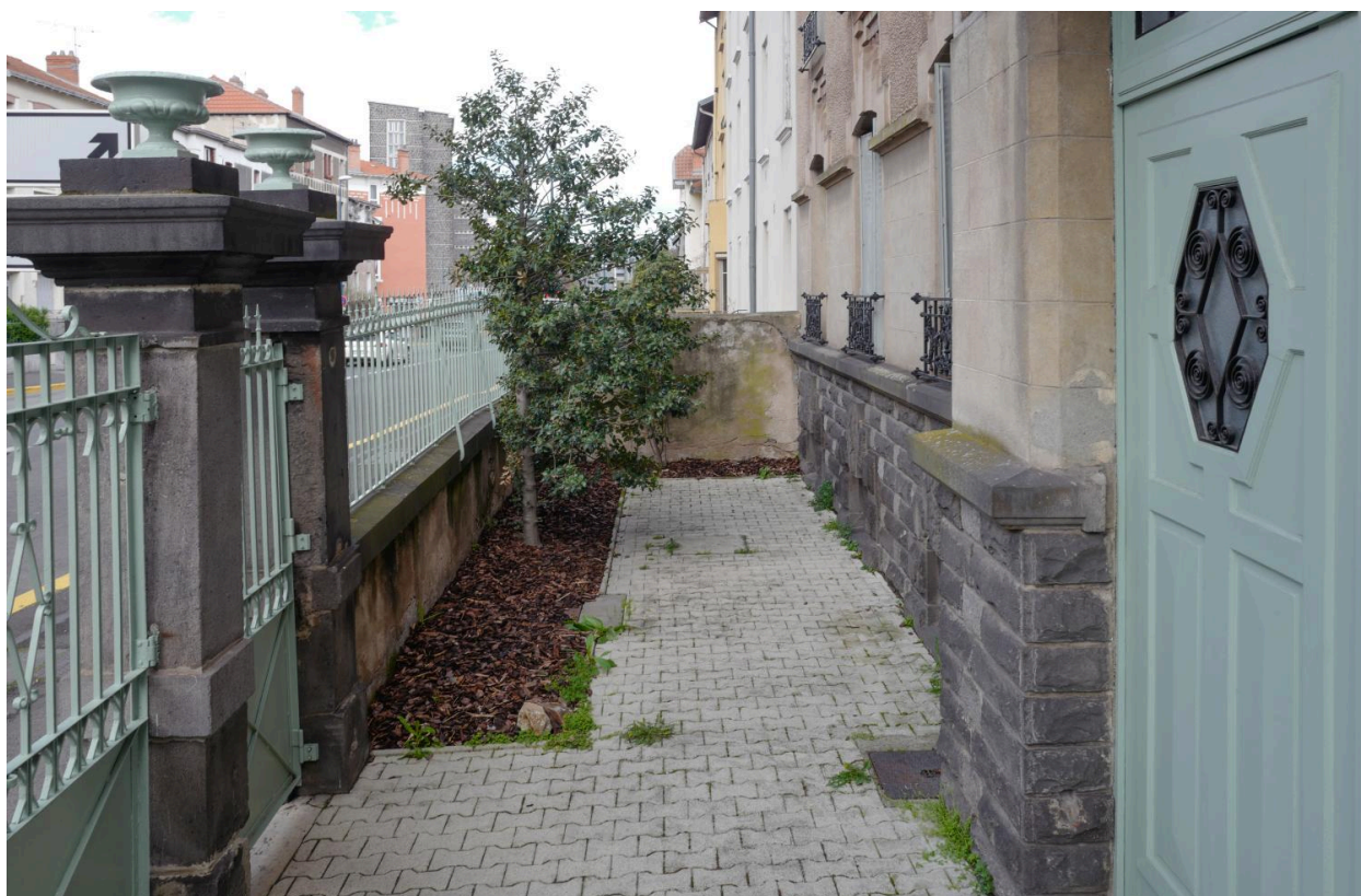
Jardinet en façade du boulevard Fleury
