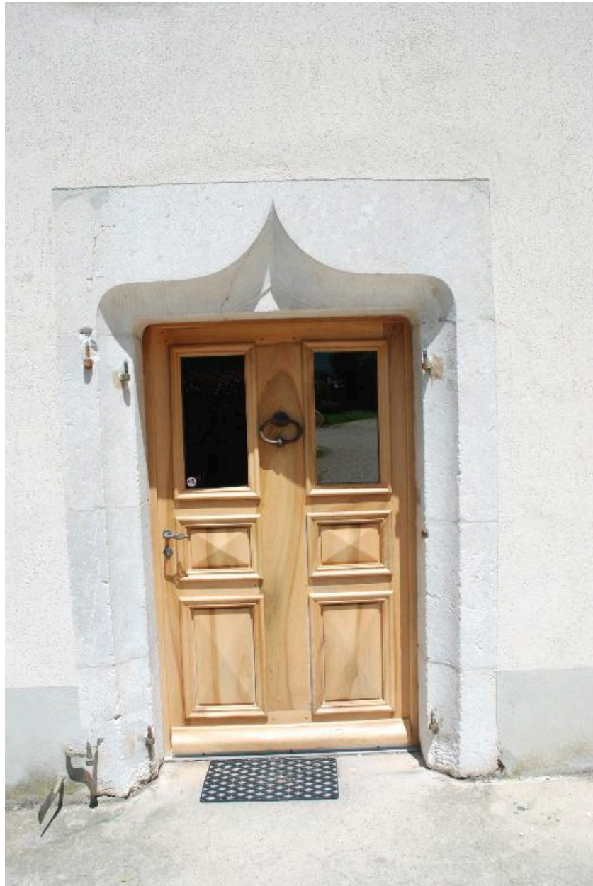
Détail de la porte d'entrée à accolade de la façade sur cour.
