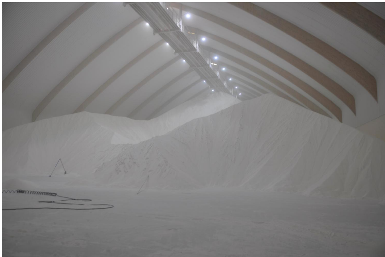
Silo : grande halle de stockage des sucres.
