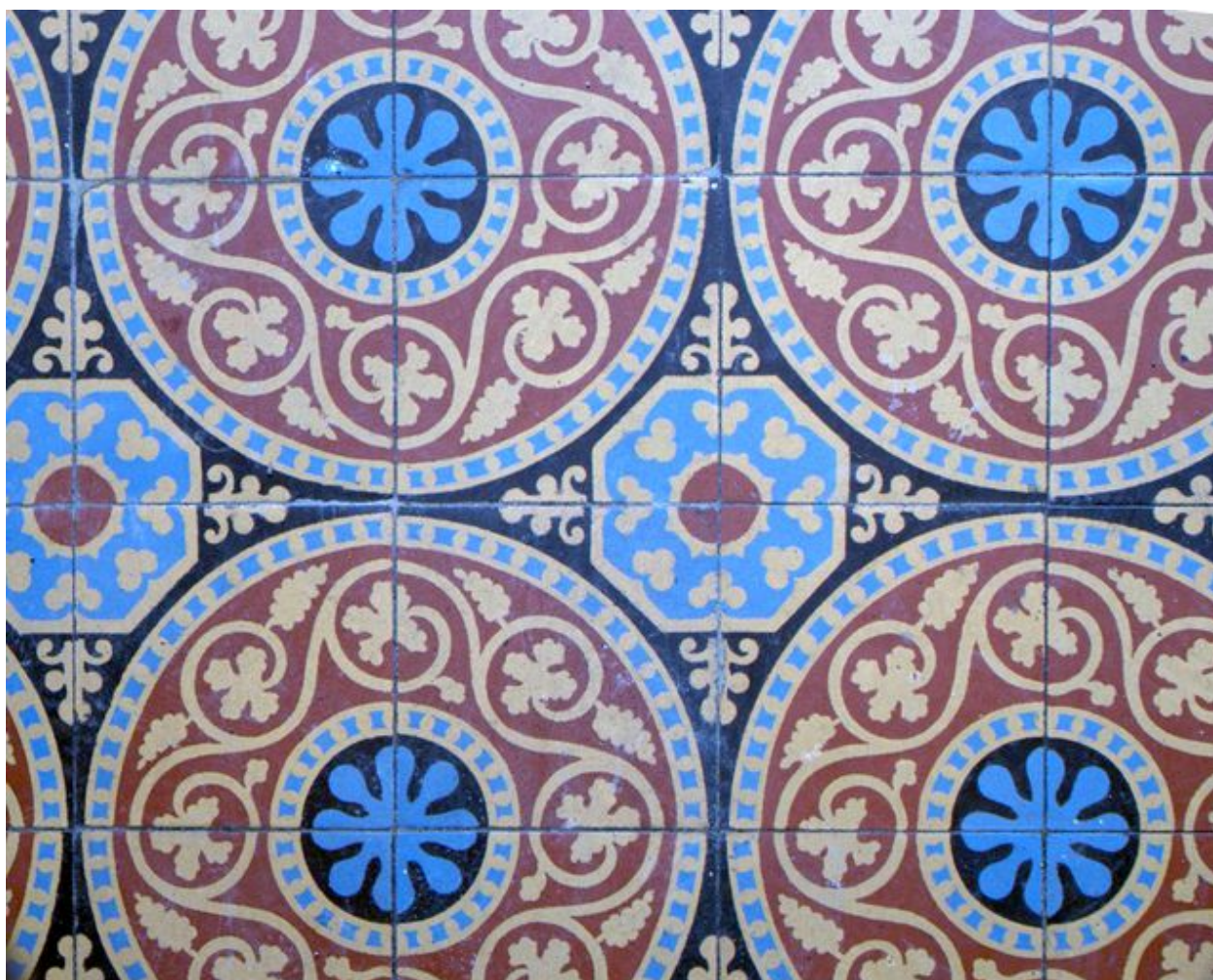
Vestibule, détail du carrelage en carreaux de ciment
