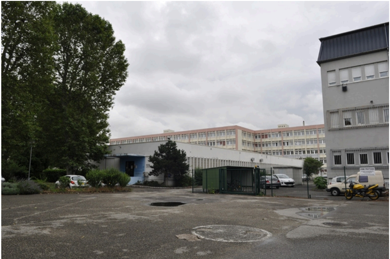
Bâtiment abritant la transmission.
