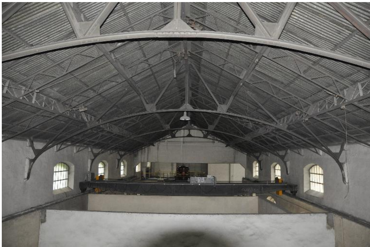
Vue de la charpente métallique de la centrale
