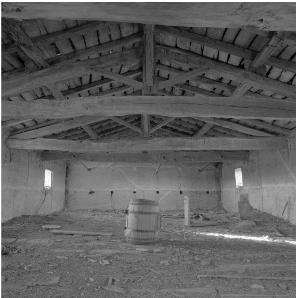
Vue intérieure du grenier, sous la charpente.
