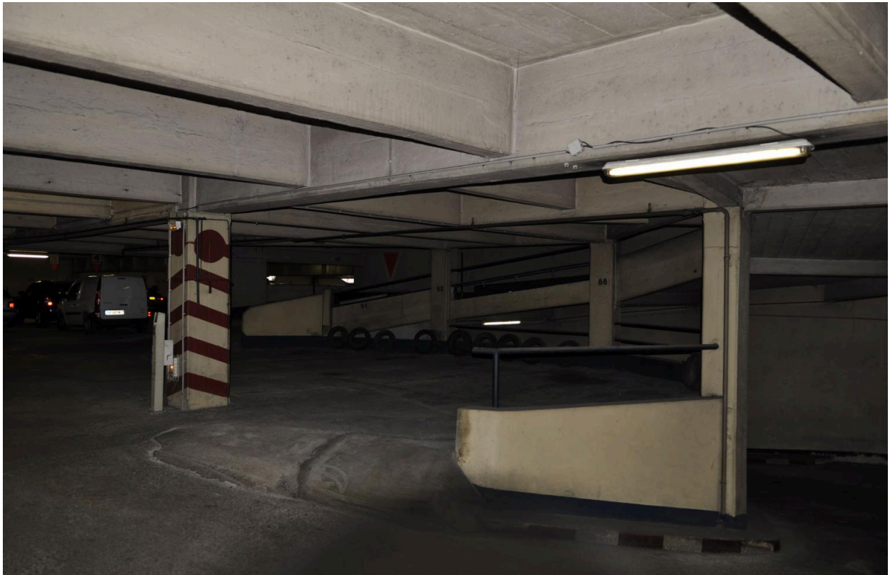
Vue intérieure du parking souterrain avec rampe d'accès
