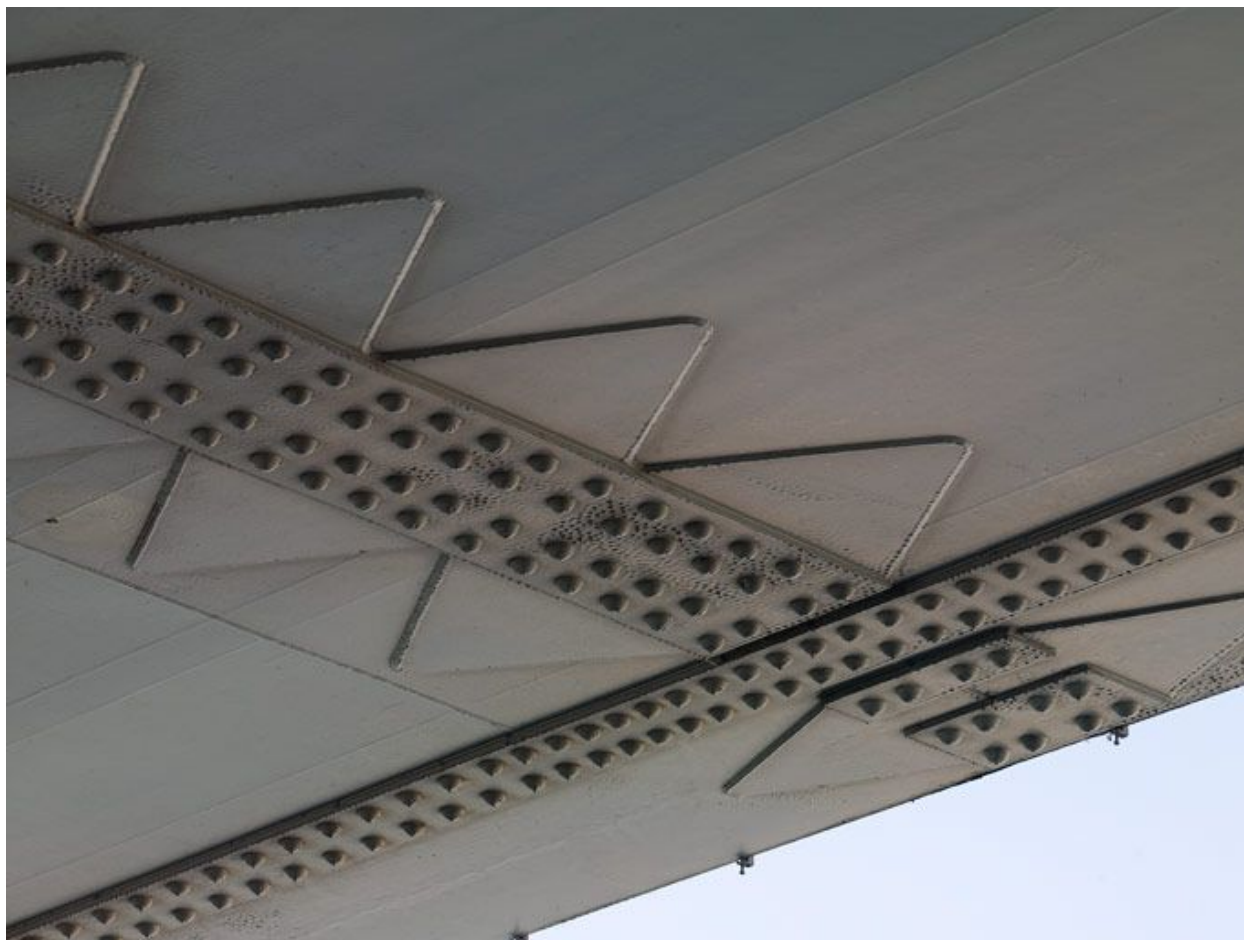
Détail de l'assemblage du tablier du pont
