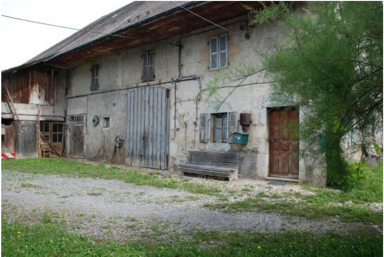
Vue du bâtiment principal.
