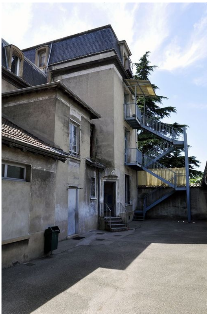
Façade postérieure, escalier de service
