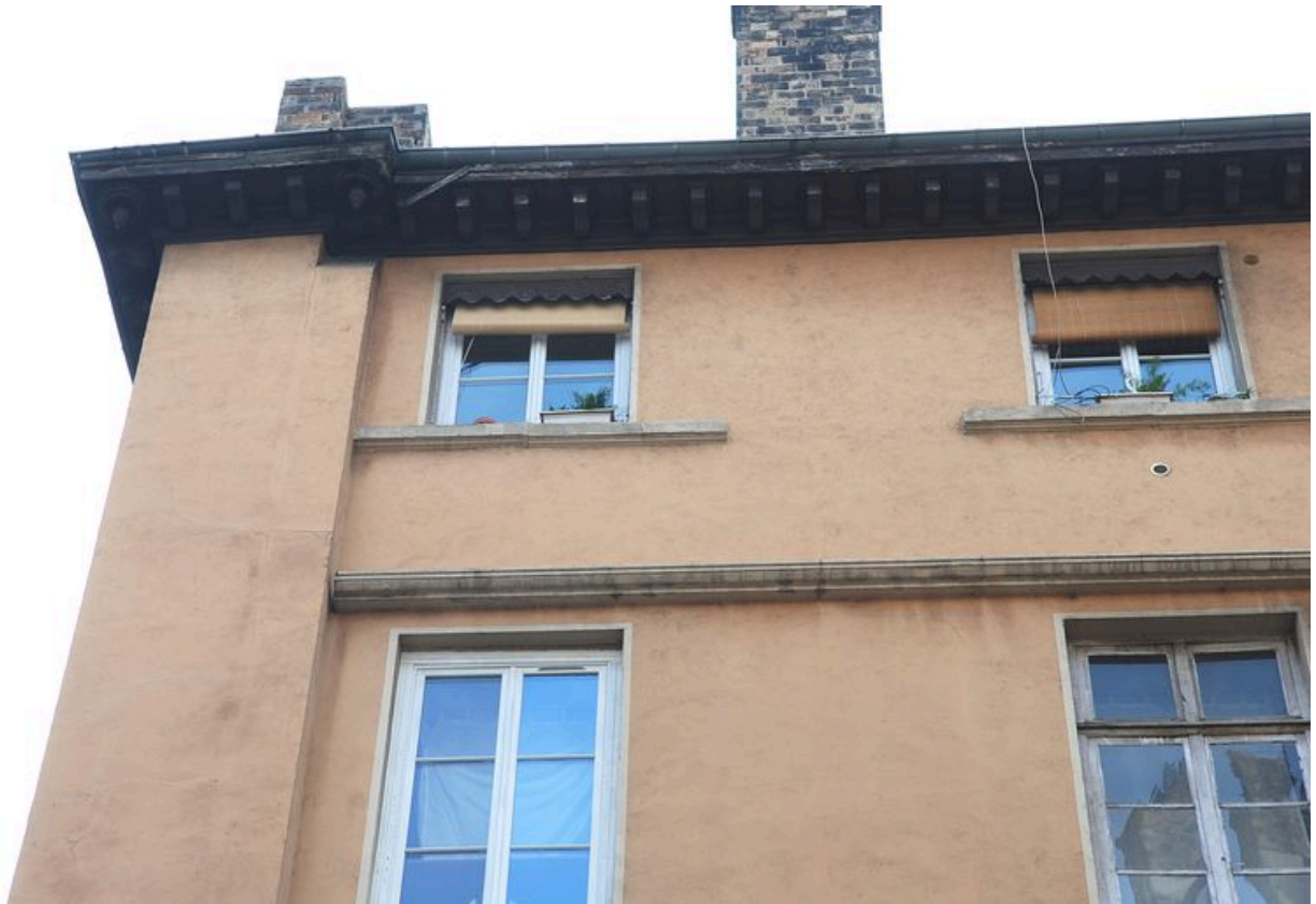
Elévation ouest : 3eme étage, moulures
