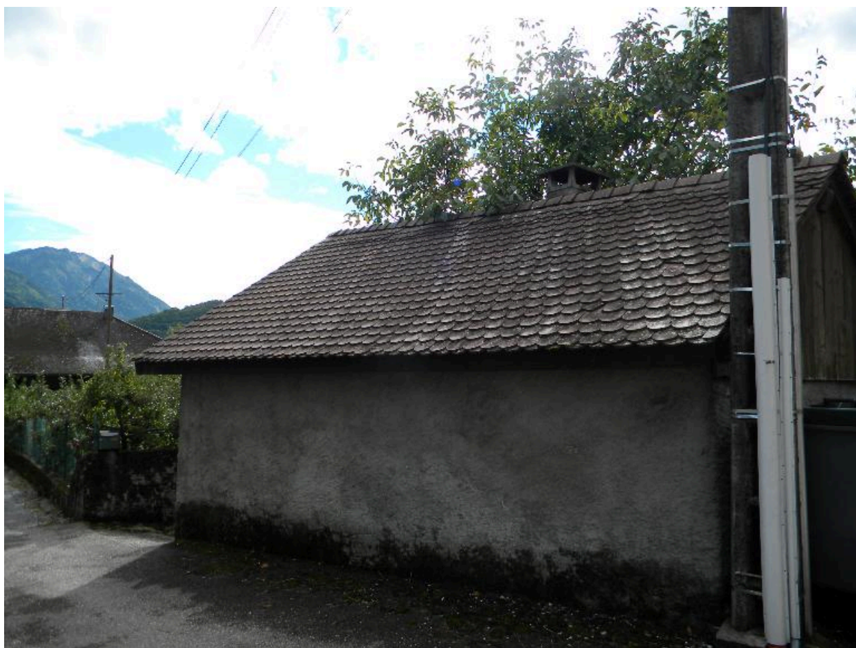
façade nord du four.
