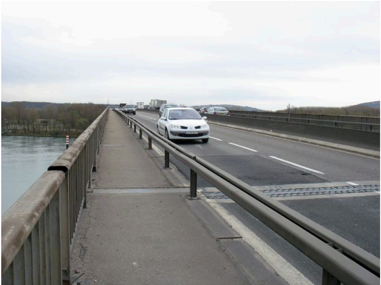
Vue sur le tablier, chaussée (depuis la rive droite)
