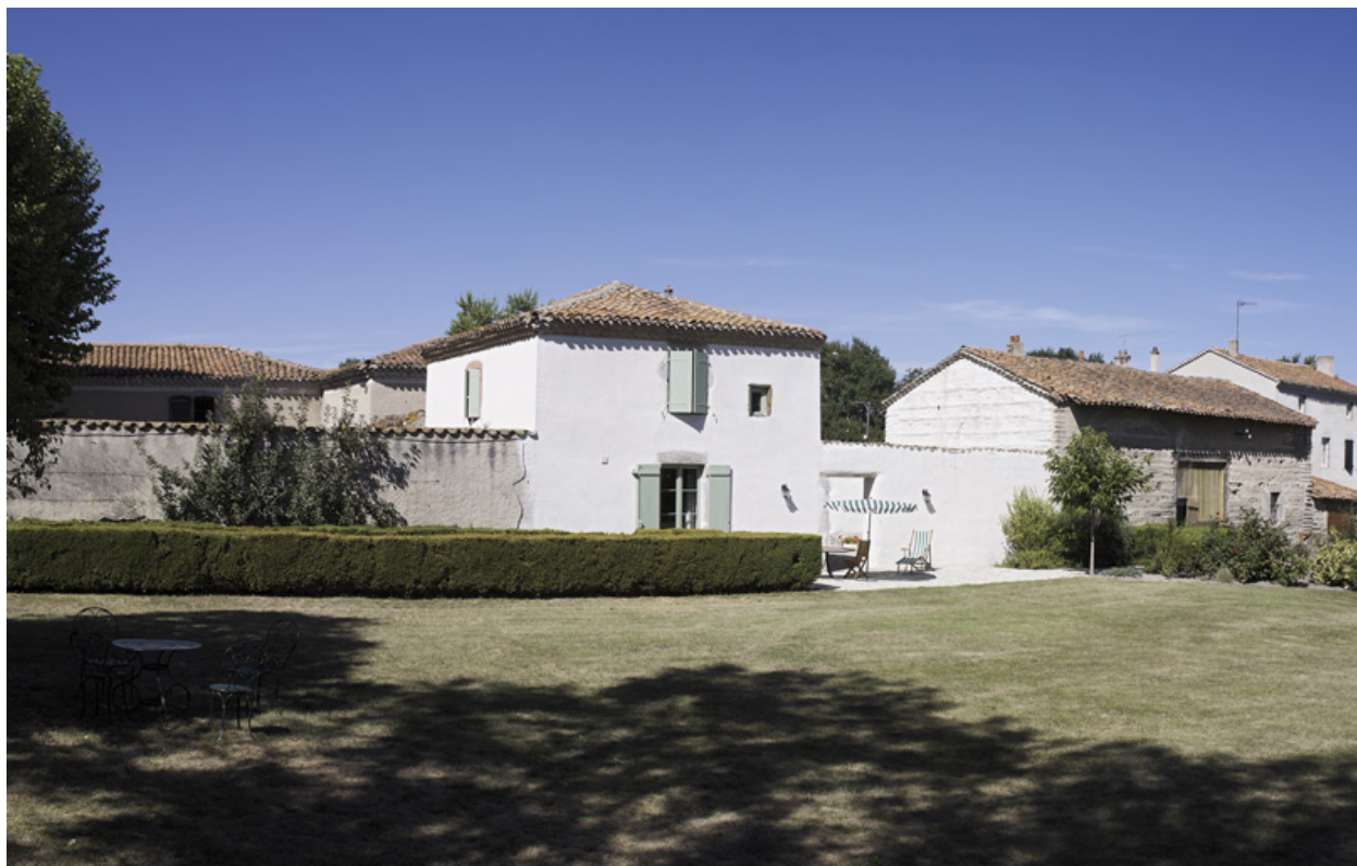
Vue de la demeure depuis le sud-ouest (cour de la demeure, pavillon sud, grange-étable).
