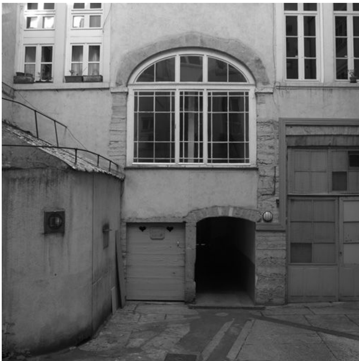
Premier bâtiment, élévation sur cour, rez-de-chaussée
