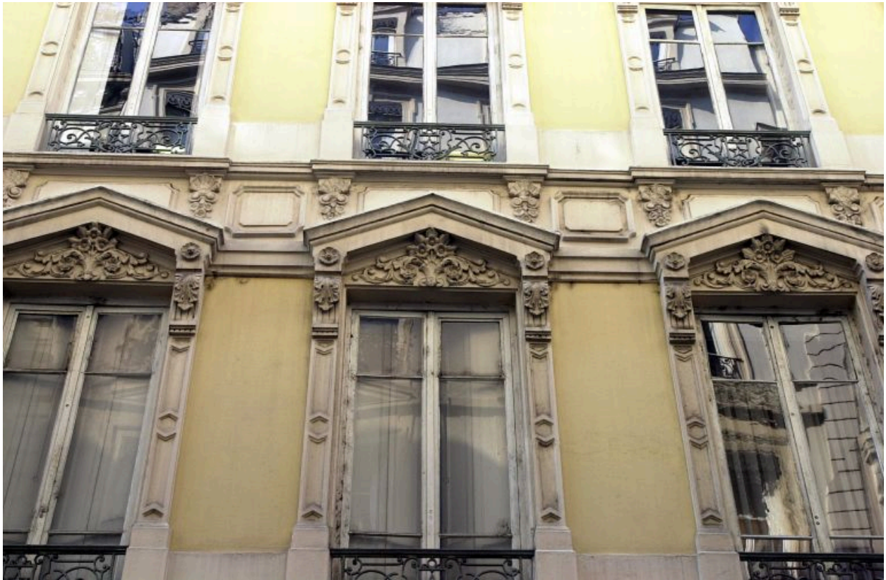
Façade rue Longue, travée centrale, détail des baies du 1er étage
