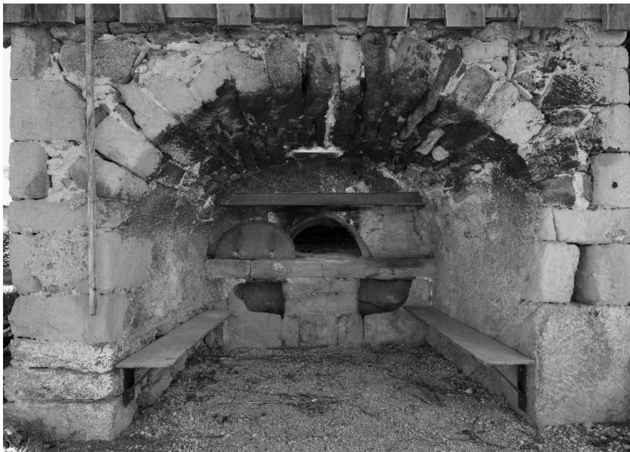
Vue d'ensemble intérieure du four à pain.
