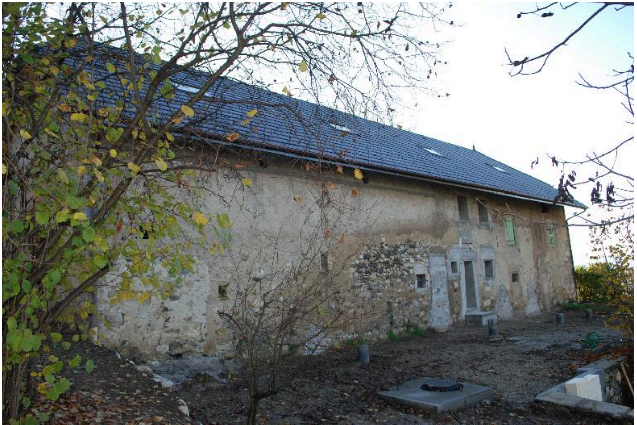
Vue d'ensemble de la façade nord de la ferme.
