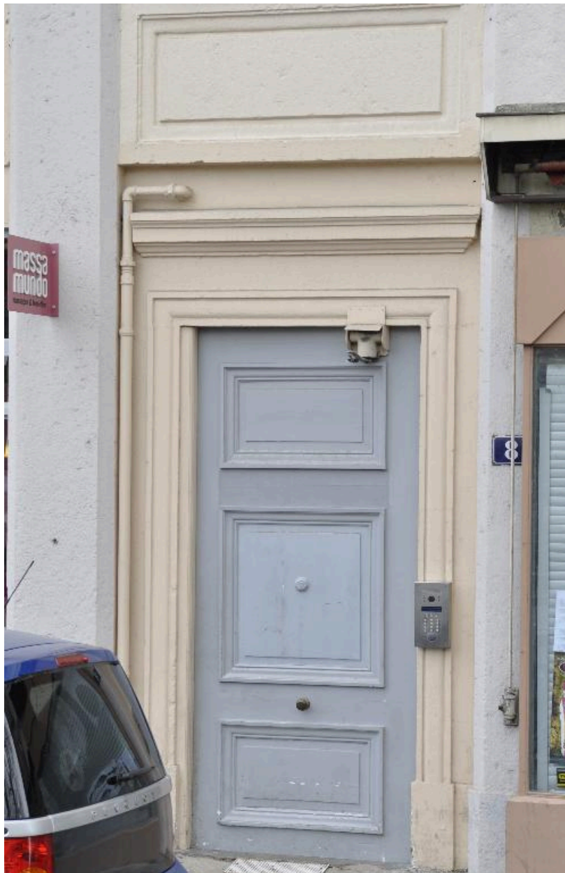
Elévation principale : porte piétonne
