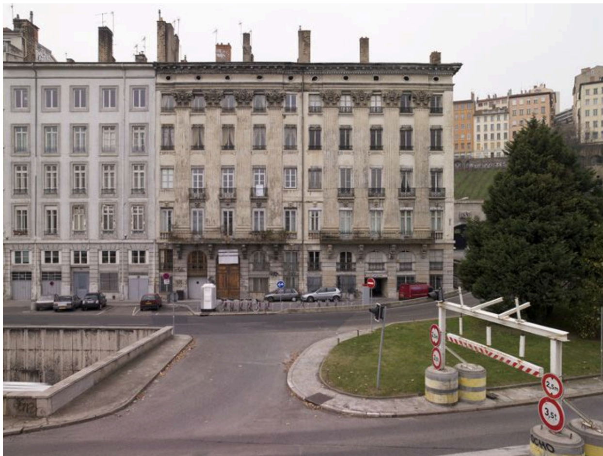
Vue de l'élévation antérieure, depuis le quai Lassaragne
