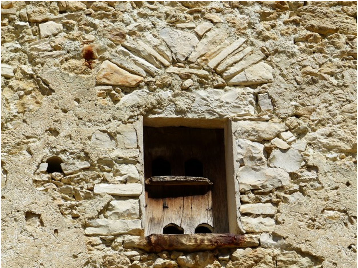
Pignon sud, deuxième niveau. Baie d'envol.
