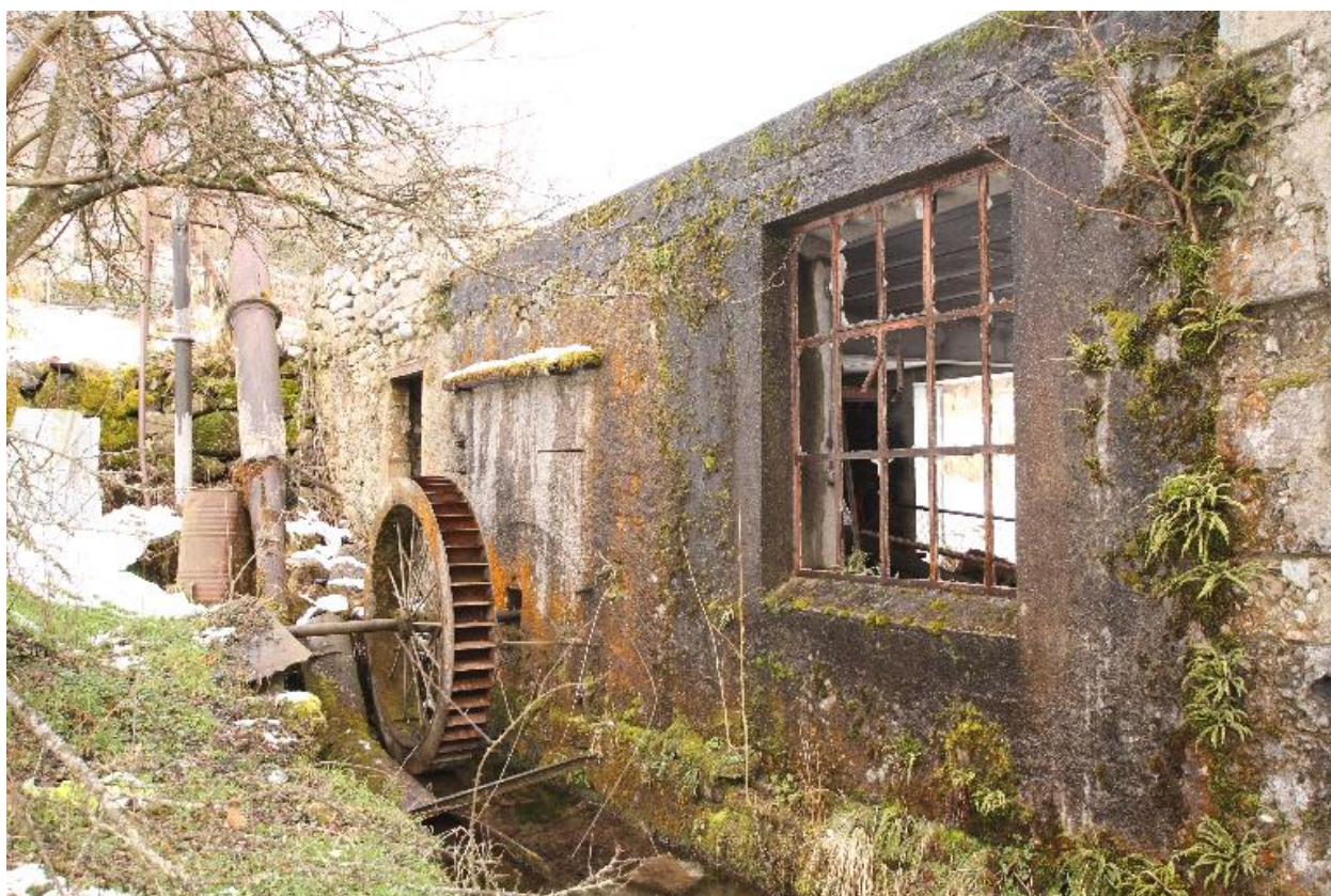
Autre vue de la roue hydraulique métallique
