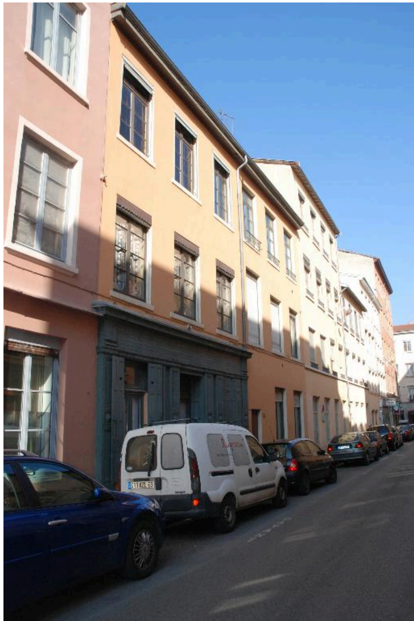
Vue d'ensemble sud est
