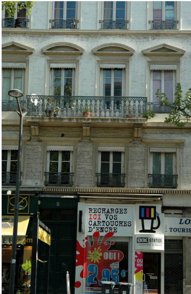
Rez-de-chaussée et travées centrales
