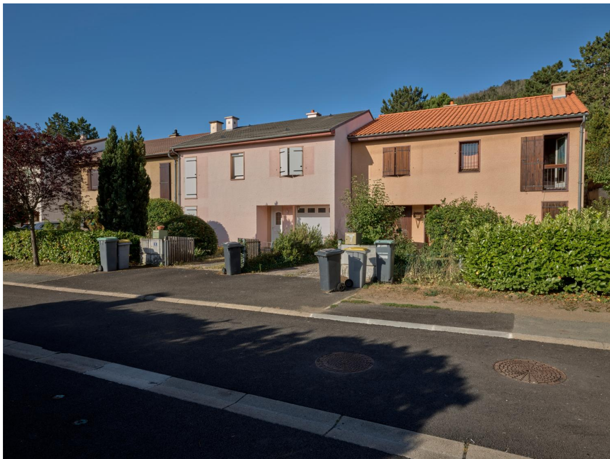
Alignement de maisons de type 5C sur la rue de la Montagnette (lotissement des Vignes, partie ouest de la cité).
