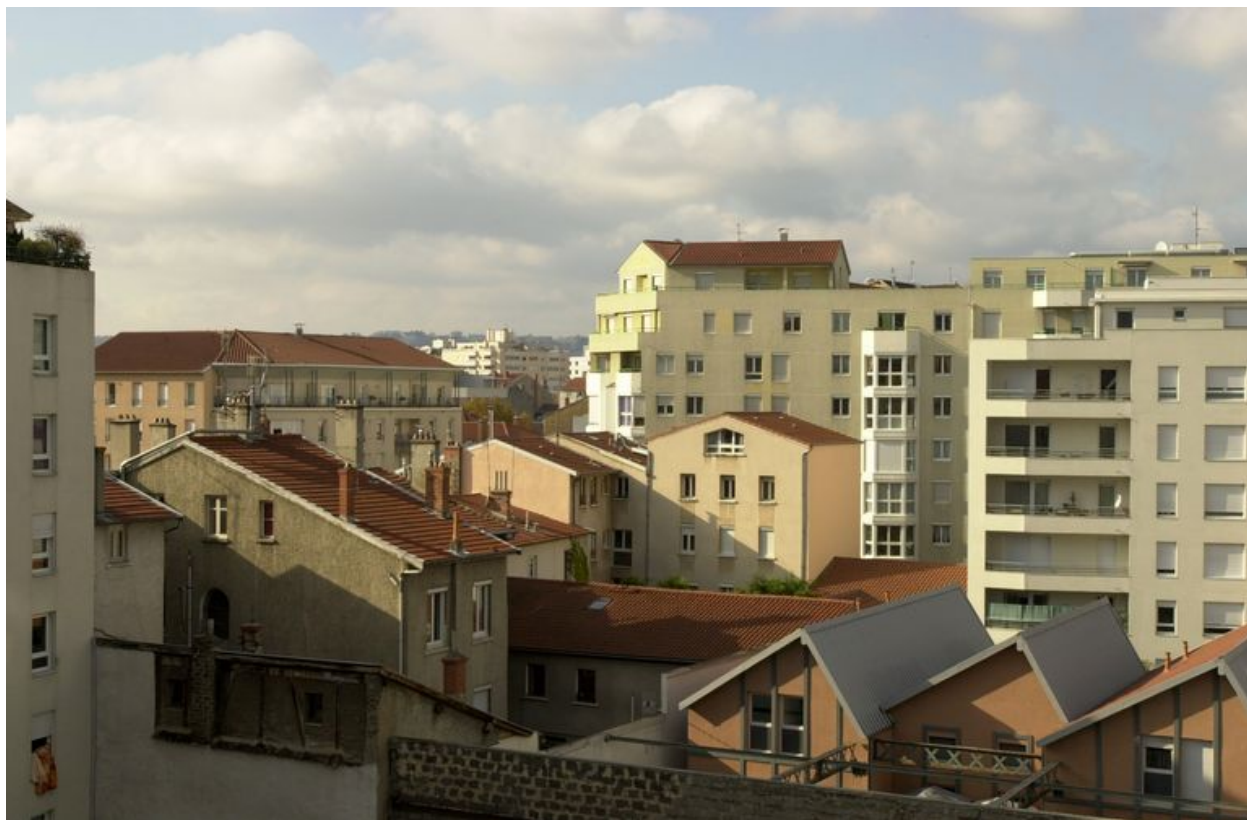
Vue des derniers niveaux depuis le nord-est
