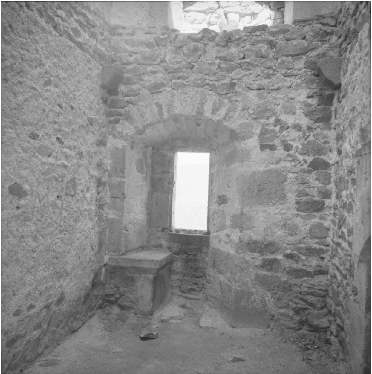
Ouvrage avancé du château fort primitif, tour carrée dite tour des Arrêts, premier étage : détail de la fenêtre à coussièges, du sud-est.
