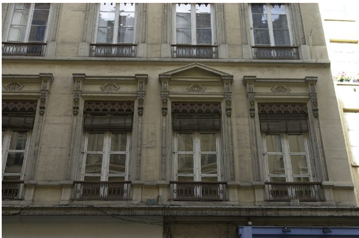
Rue de Brest : le premier étage carré
