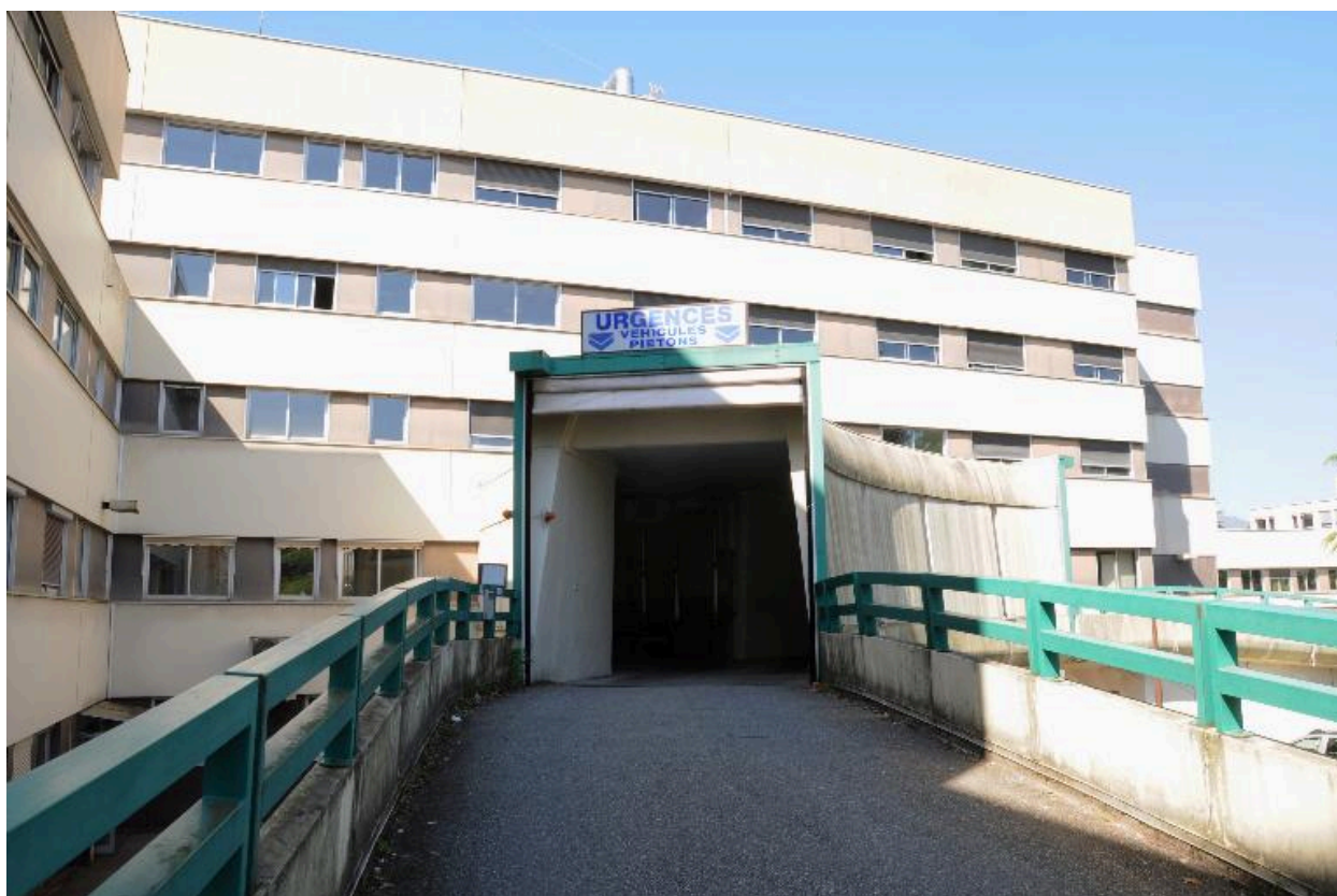
Rampe et tunnel d'accès aux urgences
