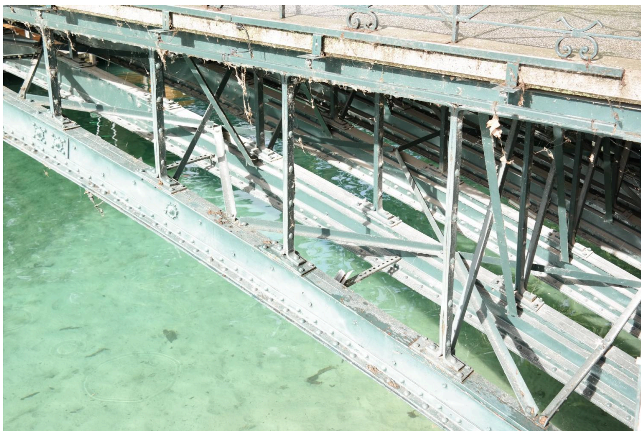
Passerelle du jardin public, dit Pont des Amours, détail des structures métalliques
