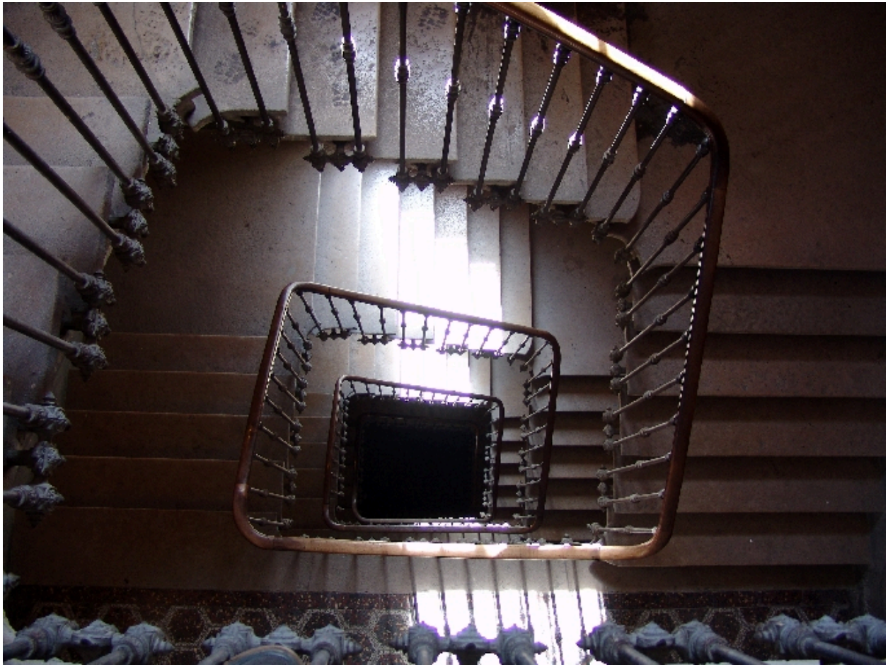
Escalier d'accès aux galeries supérieures
