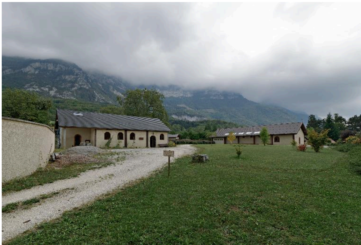
Vue d'ensemble des bâtiments rattachés au couvent : l'espace de vente et la nouvelle chapelle.
