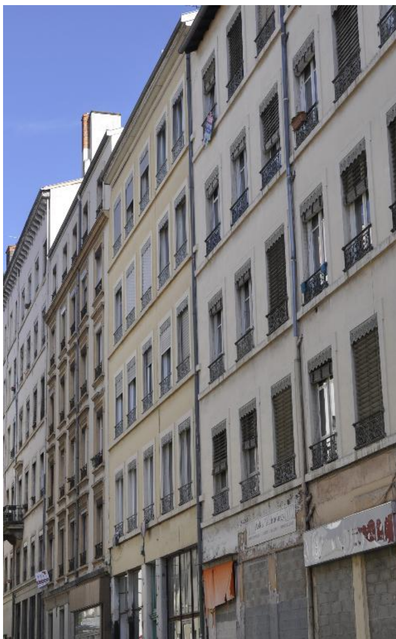
Vue d'ensemble, élévation sur rue
