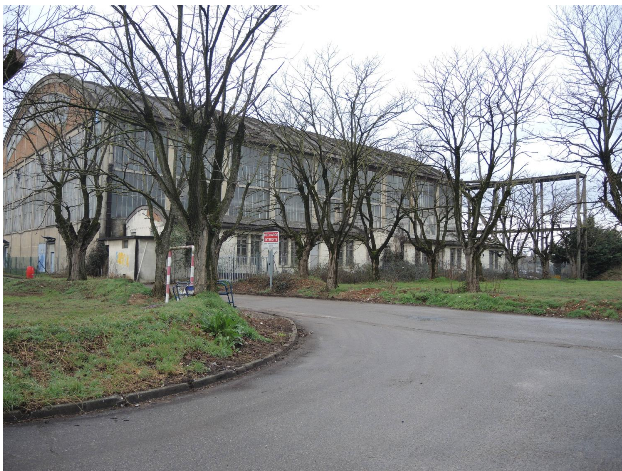
Hangar VI photo vue d'extérieur
